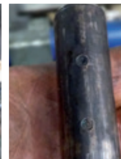
图5 拆卸时的喷淋管路
