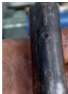
Bild 5. Besprührrohr bei Demontage der Rohrleitung.
